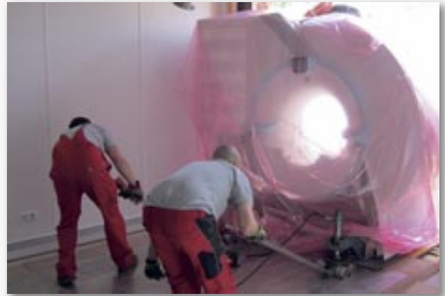
Um das MRT im Behandlungsraum aufstellen zu können, musste eigens eine Außenwand eingerissen werden.
